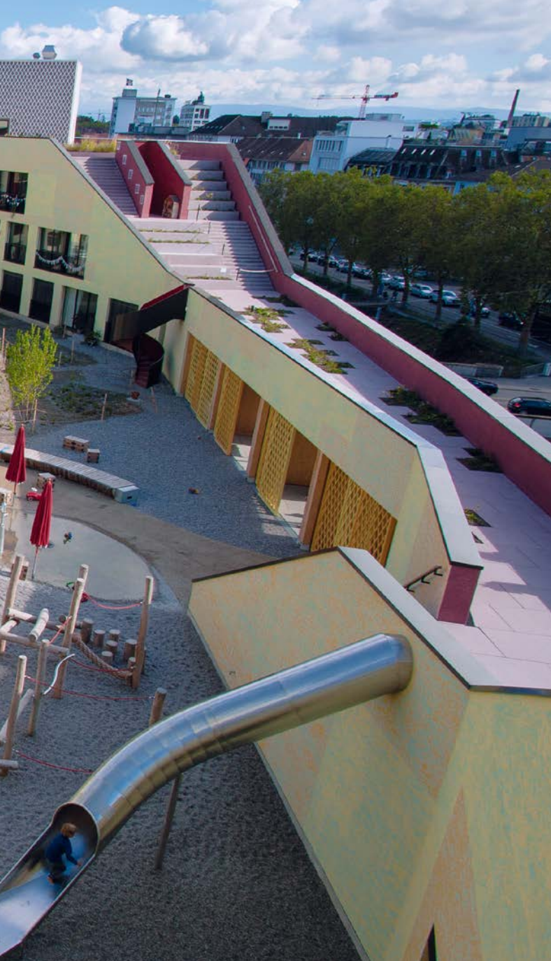
Gemeinsam statt einsam: Großzügige Gemeinschaftsbereiche ergänzen bei der Kalkbreite die knapp gehaltenen Wohnungen.
