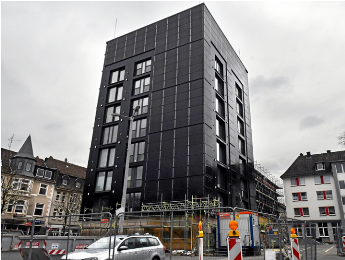
Am Bunkerturm sind inzwischen Photovoltaikpaneele installiert, weitere kommen aufs Dach.
