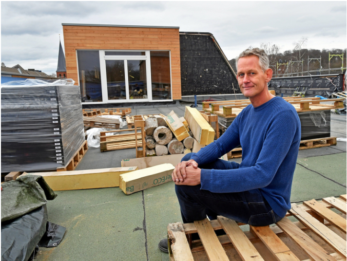
We-House-Geschäftsführer Alex Timm auf der Dachterrasse. Im Hintergrund entsteht ein Gemeinschaftsraum samt Sauna.
